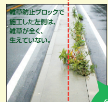
雑草防止 ブロックで施工
